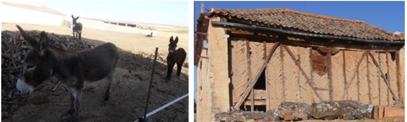
Fig. 12 y 13. Borriquillos en un cercado. Pared con entramado de madera y adobe, Otones de Benjumea.
