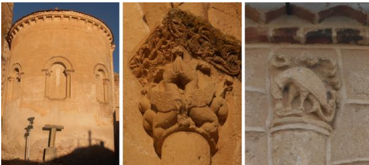
Fig. nº 16, 17 y 18. Abside. Capitel del abside. Figura incrustada en el muro sur. Iglesia de la Asunción. Torreiglesias.
