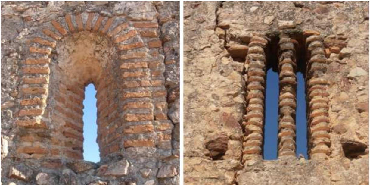
**Fig. 9 y 10. Vanos reforzados con ladrillo. Ermita de San Cebrián.**
