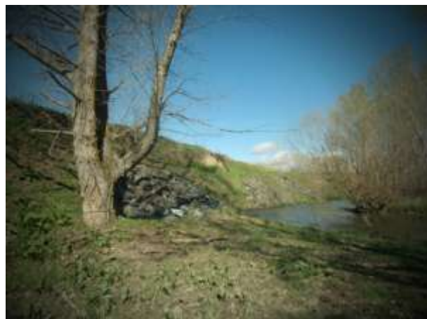
Fig. 22. Meandro del río Pirón. Lanchal de lajas de pizarra desprendidas de la masa rocosa.
