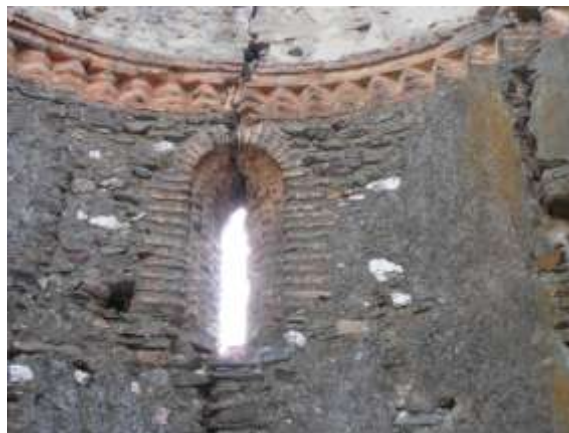
Fig. 19. Ventana y banda decorativa de ladrillo del ábside
