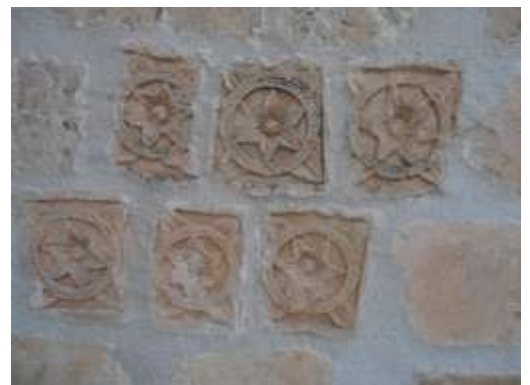
Fig. 15. Dovelas románicas en los contrafuertes del muro norte.
