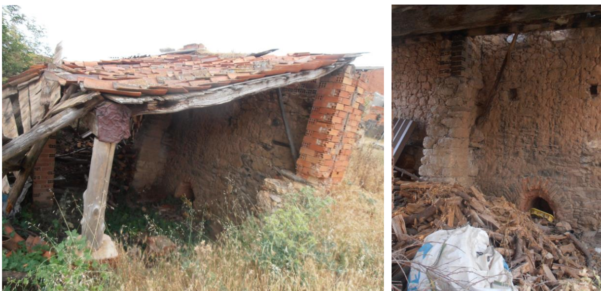
Fig. 8 y 9: Tejadillo y boca de la caldera. Tejera de Carbonero el Mayor
