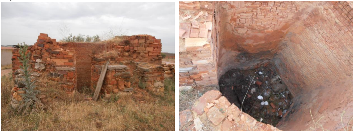
Fig. 10 y 11. Cuerpo de la cámara de cocción. Cámara de cocción vista desde arriba.
