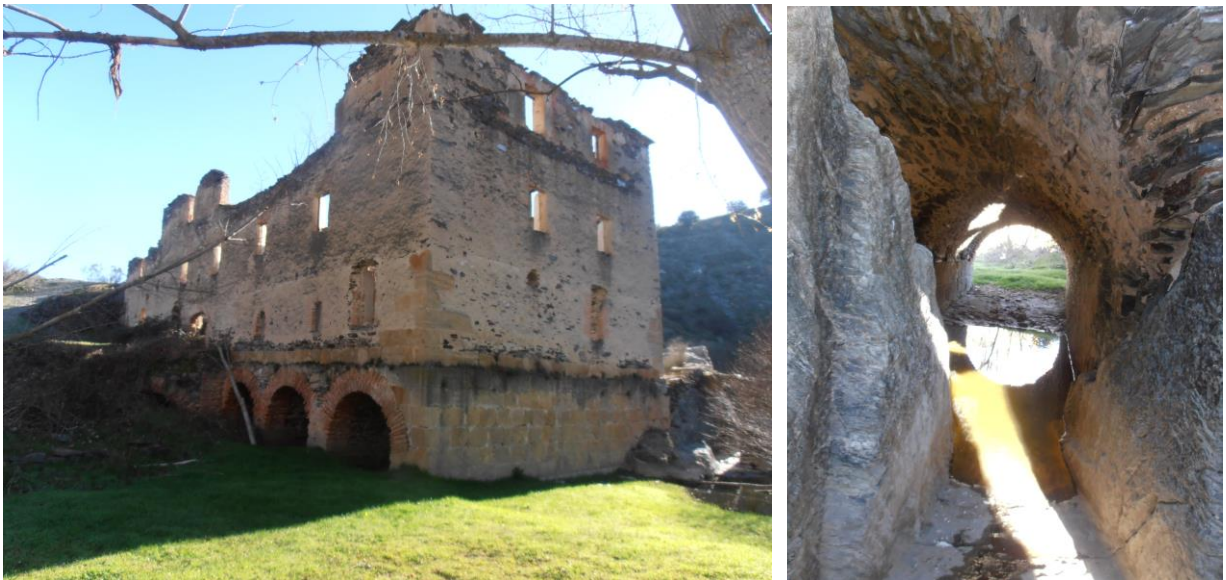
Fig. 23 y 24. Paredones y bóveda labrada ente pizarras del molino de Fuentes.
